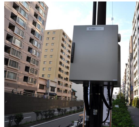
冠水ユニット制御ボックス:コンパクトなサイズで軽量です。
